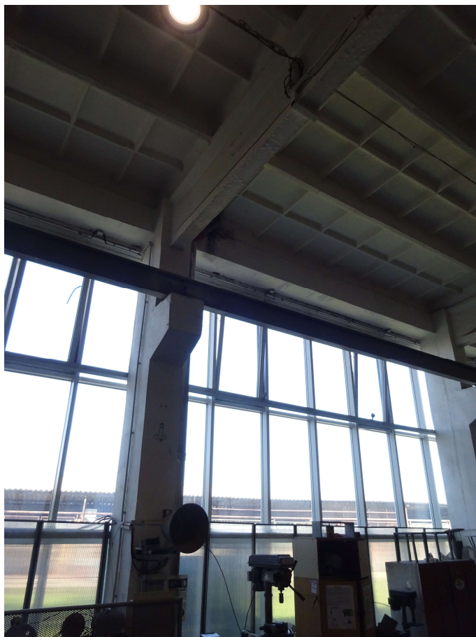
Průvlak uložený na sloup
